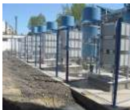
2 baterii de compensare a energiei reactive cu 6 trepte de reglare pentru rețele de medie tensiune (inclusiv cu filtre pe armonici). 52,4 MVar. Feral Tulcea, România.
