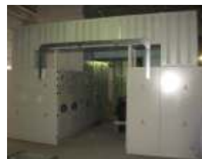
2 baterii de compensare a energiei reactive cu 6 trepte de reglare pentru rețele de medie tensiune (inclusiv cu filtre pe armonici). 52,4 MVar. Feral Tulcea, România.
