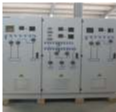
Dulapuri pentru alimentare de joasă tensiune de curent continuu și curent alternativ (400/220/110kV). Stația Brașov - Transelectrica, România.
